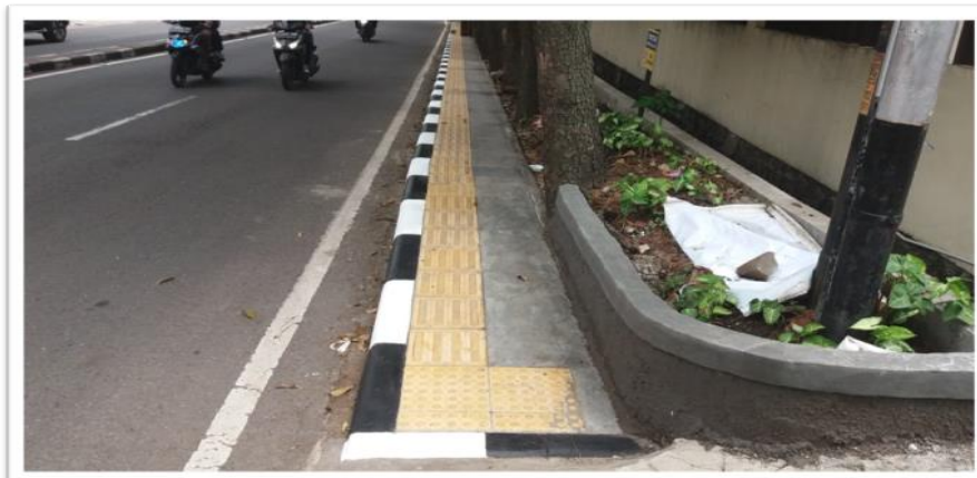
Gambar 7. Trotoar yang telah selesai diperbaiki dengan tambahan fasilitas penyandang disabilitas dengan tongkat di sekitar Gerbang 1 Universitas Kristen Maranatha
