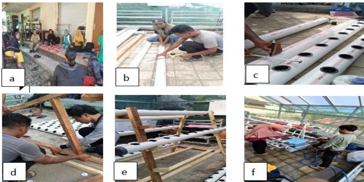
Gambar 1. (a) sosialisasi, (b) pemotongan pipa dan kayu, (c) menyusun jalur instalasi, (d) merakit penopang, (e) merakit sistem hidroponik NFT, (f) finishing
