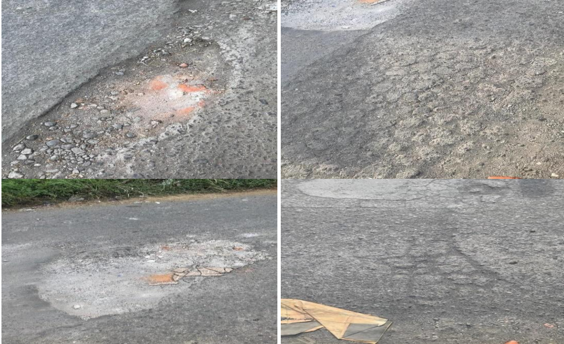
Gambar 9. Rusak Tepi, Retak Kulit Buaya, dan Tambalan STA 0+300–STA 0+400
