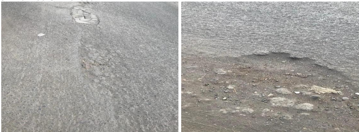
Gambar 8. Retak Kulit Buaya dan Rusak Tepi STA 0+200–STA 0+300
