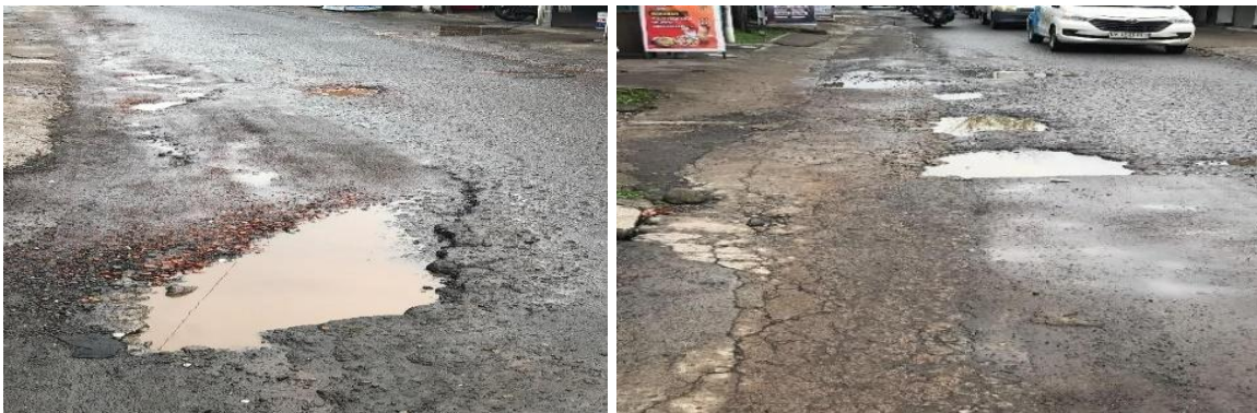
Gambar 10. Rusak Tepi dan Lubang STA 0+400–STA 0+500
