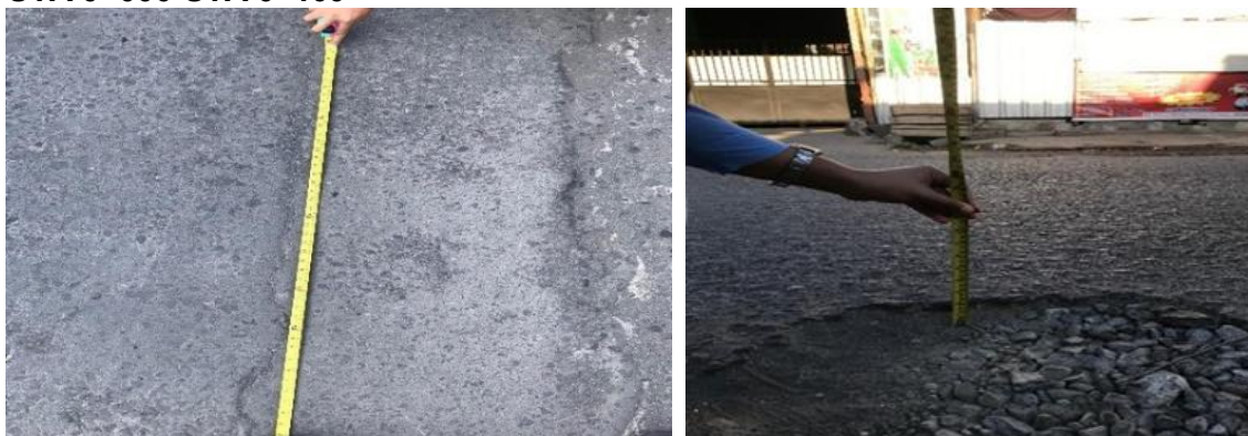
Gambar 6. Retak dan Lubang STA 0+000–STA 0+100
