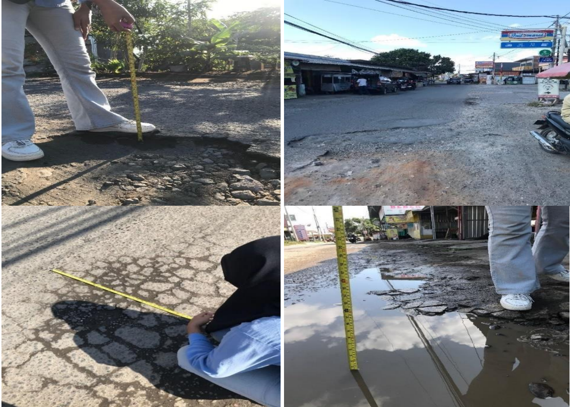
Gambar 7. Retak Kulit Buaya, Lubang dan Rusak Tepi STA 0+100–STA 0+200
