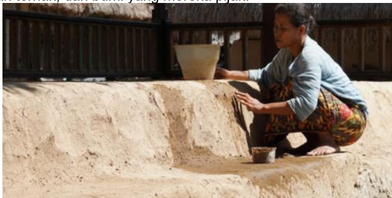
Gambar 5. Lantai dibalut Kotoran Ternak dan Tanah Liat Sumber: Dokumentasi Penulis, 2026
