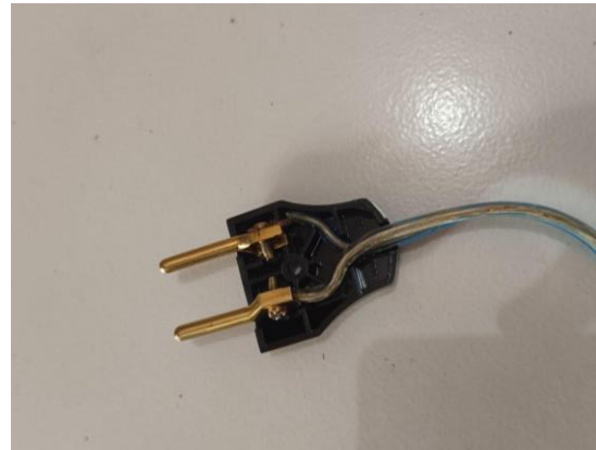
Gambar 8 Pemasangan kabel fasa dan netral ke stecker
