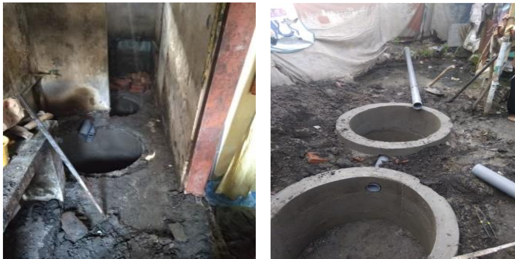
Gambar 9. Pemasangan bus beton jadi untuk lahan terbatas.
