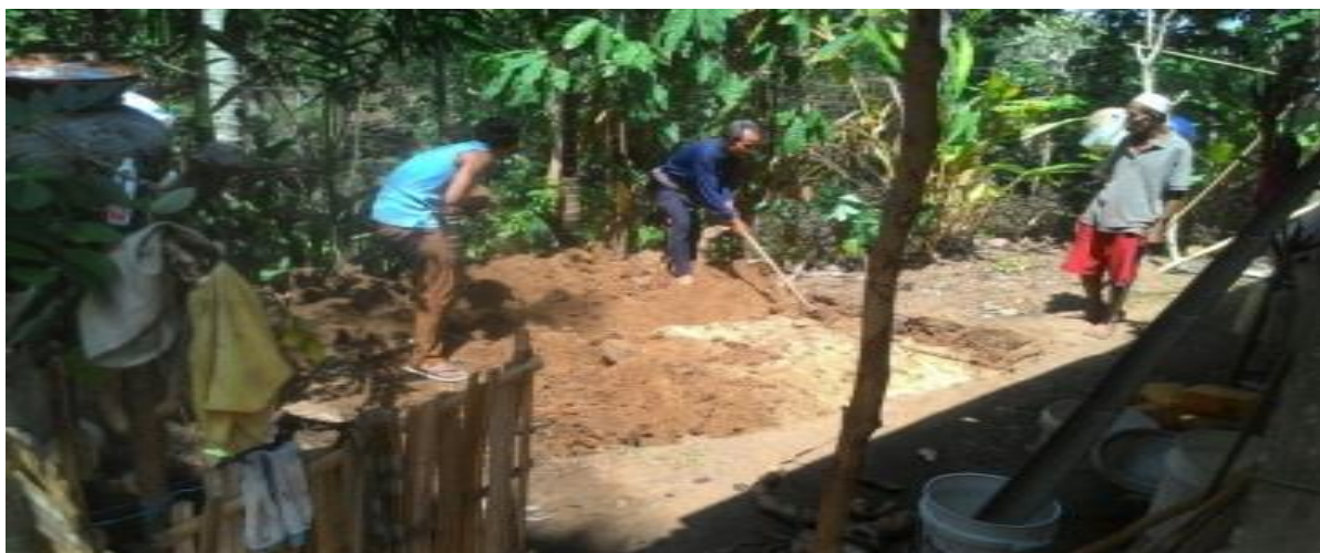
Gambar 2. Proses Pembuatan Bak Penampung Air Hujan
