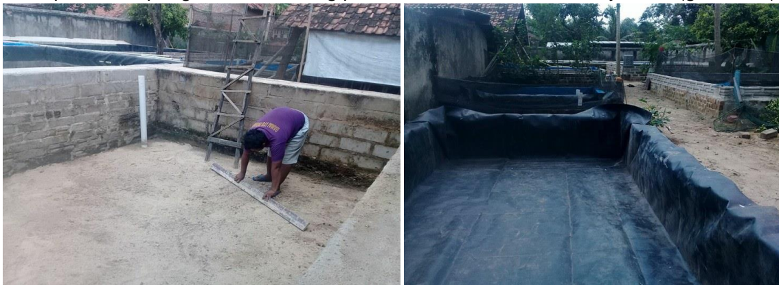
Gambar 1. Proses pembuatan kolam dan meratakan tanah pada kolam
