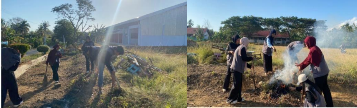
Gambar 2 Kondisi lokasi sebelum dan pada tahap awal pembersihan.
